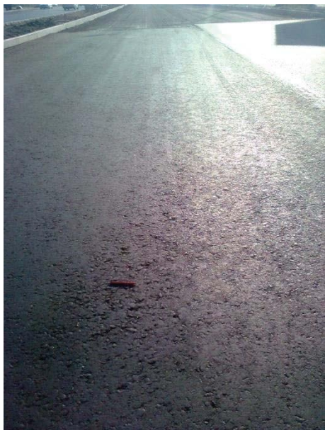
Рис. 4. Механічна сегрегація
