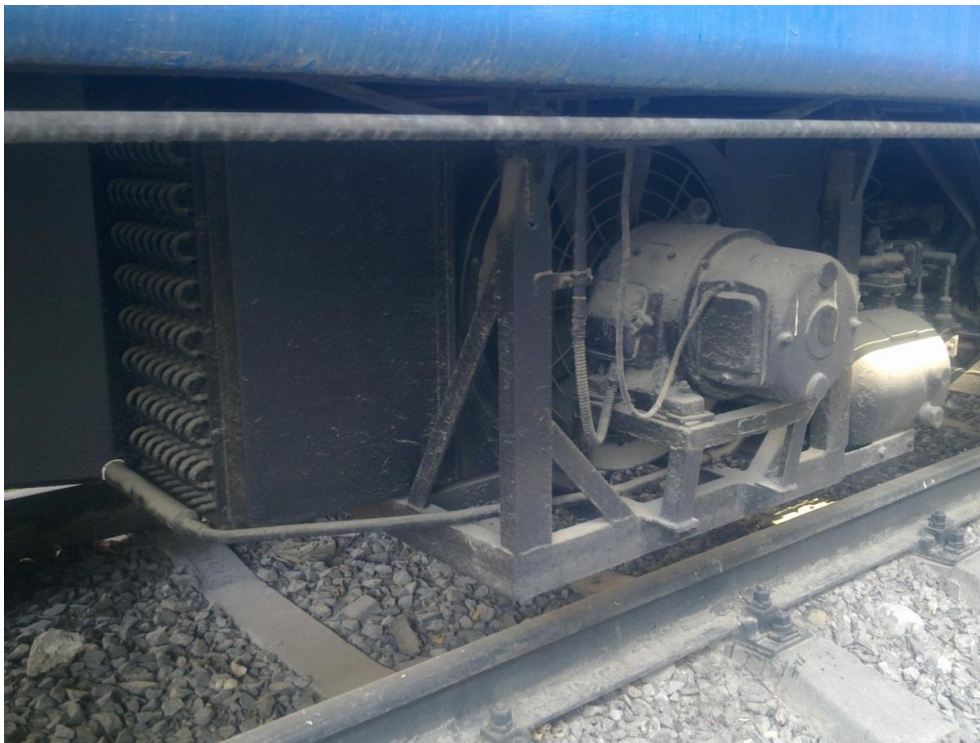
Рис. 3.4. Загальний вигляд конденсаторного агрегату установки МАВ-II
