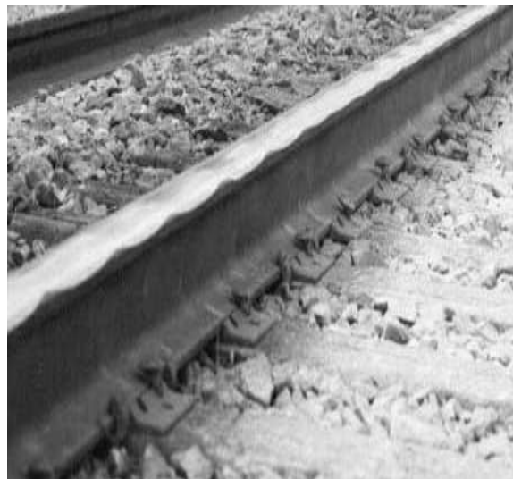
Рис. 2. Сильный волнообразный износ головки рельса
