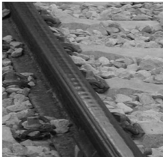
Рис. 1. Начальная волнообразная деформация головки рельса
