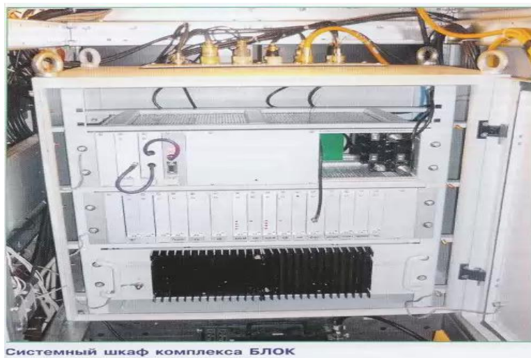
Рис. Системна шафа комплексу блок
