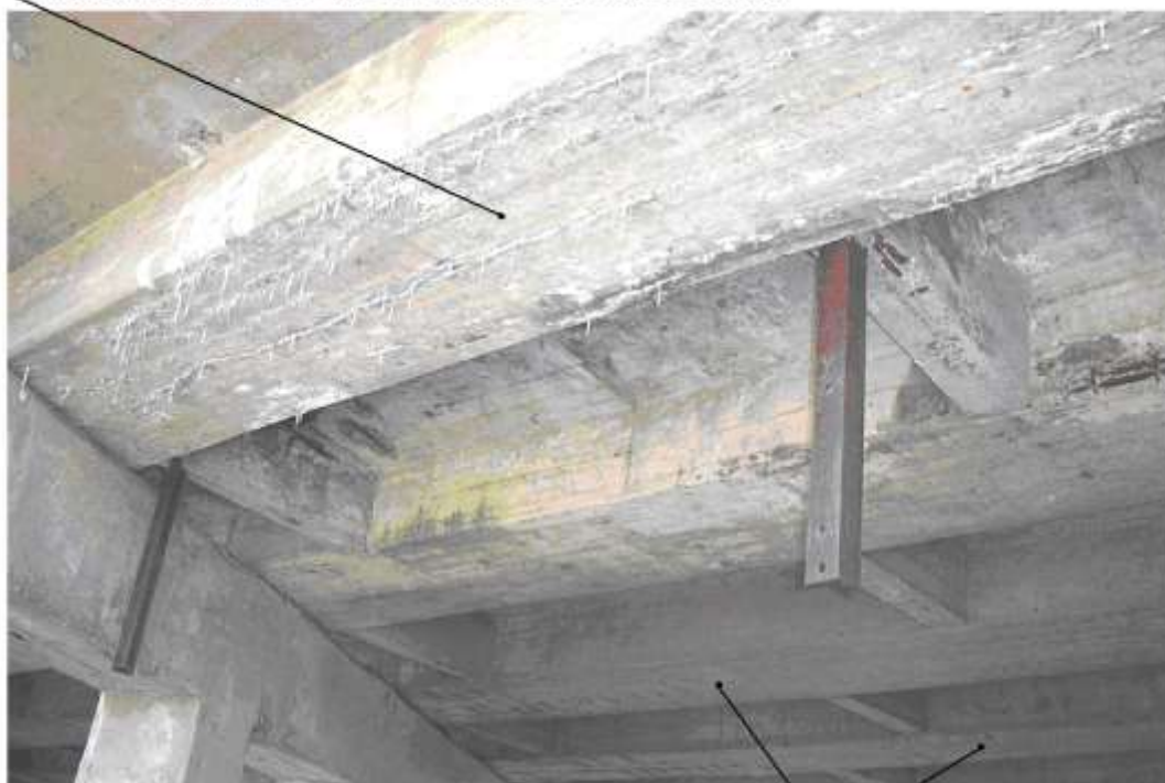
Балки средних пролетных строений
