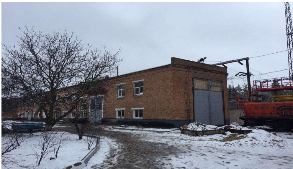
Рис. 1. Загальний вигляд тягової підстанції № 18 м. Зміїв
